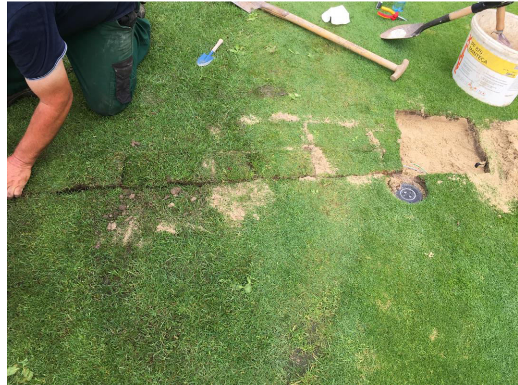
Einsetzen der Rasenziegel
